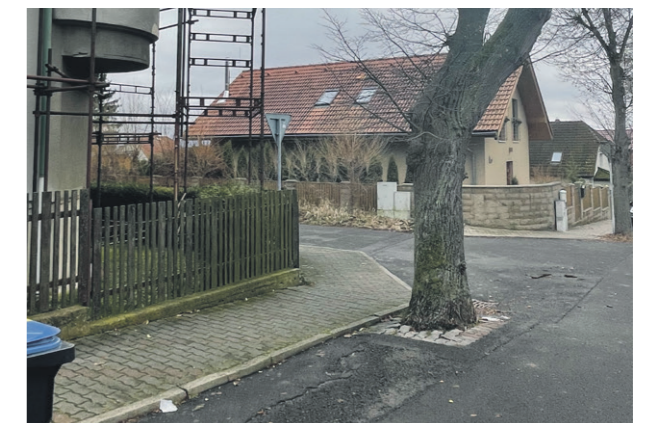
18 DODLÁŽDĚNÍ AŽ KE KMENI STROMU
