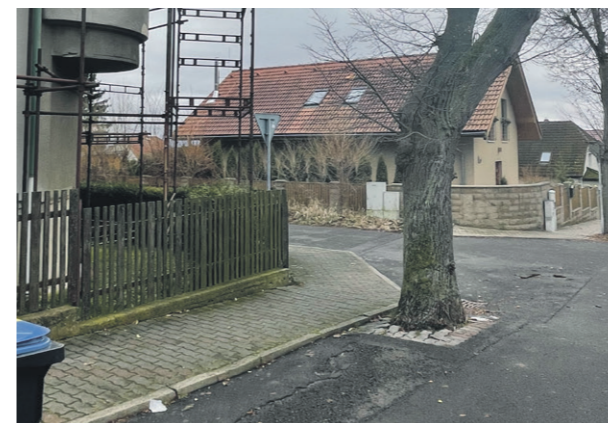
15 DODLÁŽDĚNÍ AŽ KE KMENI STROMU
