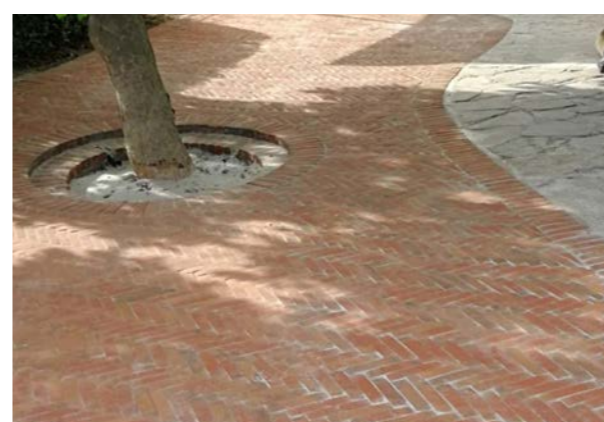
CIHLOVÁ DLAŽBA je ve veřejném prostoru v části lokálního centra a v předzahrádkách jako nasměrování ke vstupům
