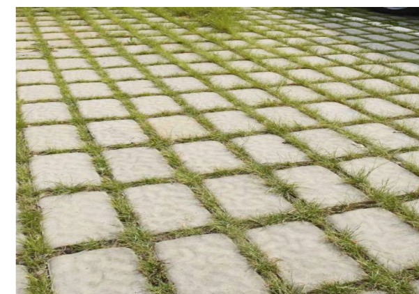
VSAKOVACÍ DLAŽBA SE ZELENOU SPÁROU používáme jí pro parkovací místa a na rozhraní zahrady a chodníku
