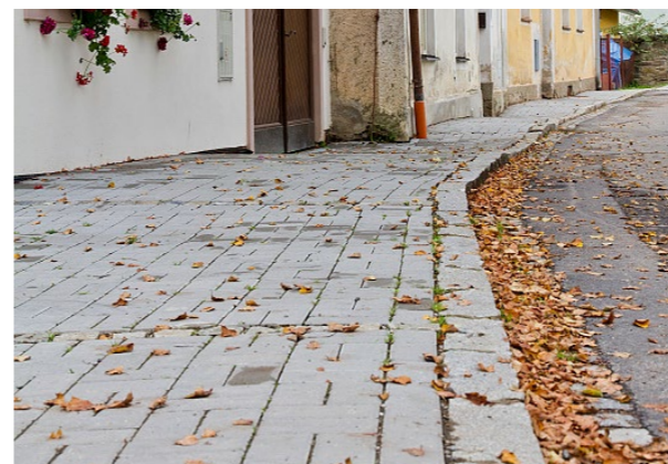
BETONOVÁ DLAŽBA A ŽULOVÝ OBRUBNÍK žulové obrubníky zasezené do betonu zpomalí auta a zvýší bezpečnost chodců
