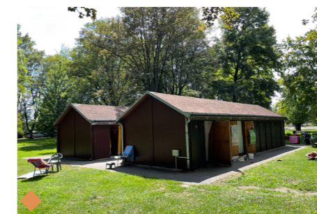
Objekty soukromých převlékárny
