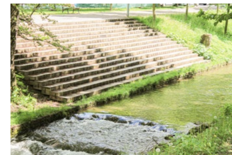
5 Nábřeží Biliny je zvýrazněné pobytovými schody a dosadbou stromů.
