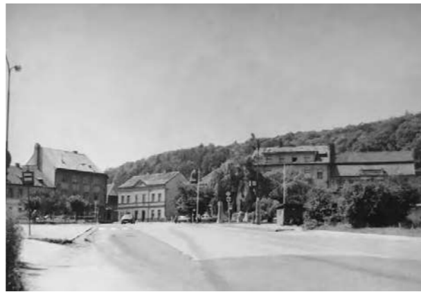
pohled na asfaltovou plochu náměstí 80.léta
