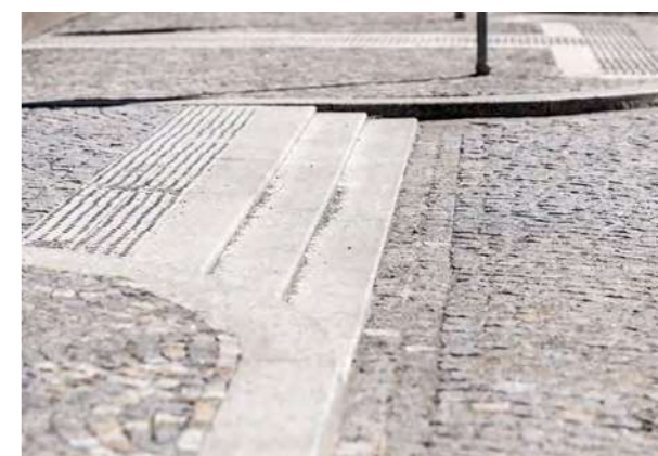
důraz na kvalitní detaily provedené v kameni (např. obruby, prahy, řešení detailů pro nevidomé atd.)
