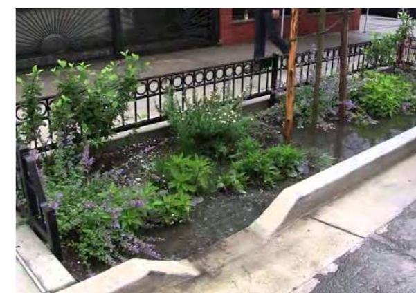
vedení vody skrze sníženou obrubu
