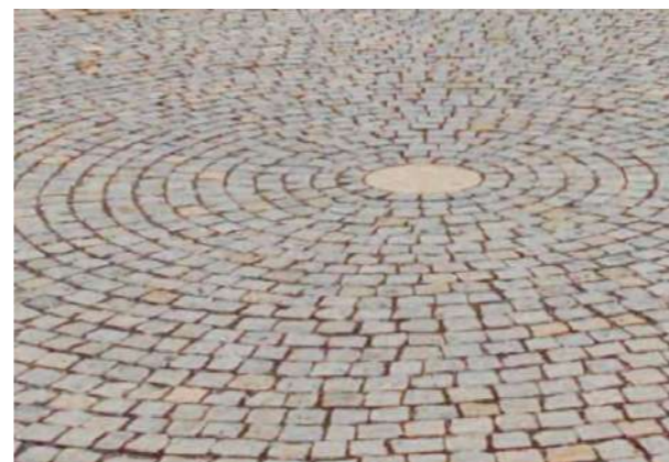
hlavní plocha náměstí – žulová kostka 10/10 štípaná kladená do kružnic okolo kameného terče
