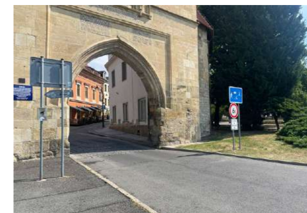
NEVHODNÉ UMÍSTĚNÍ ZNAČEK A POUŽITÍ ASFALTU
