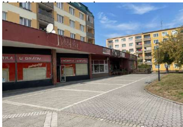
ROVNÁ PLOCHA PŘED PARTEREM PANELOVÉHO DOMU
