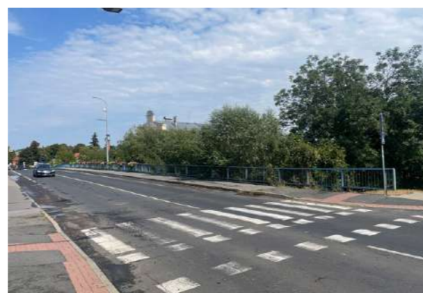
MOST PŘES ŘEKU
