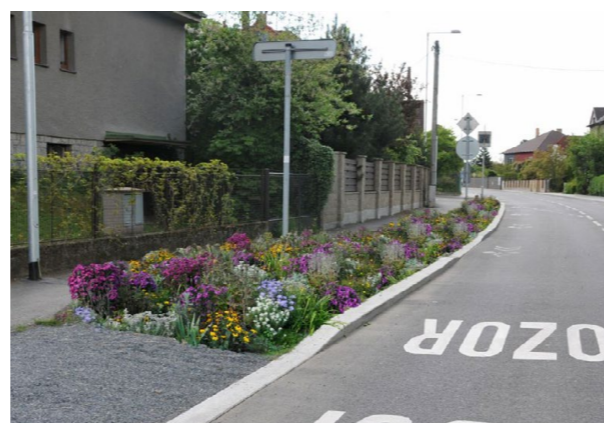
BAREVNÉ DEŠŤOVÉ ZÁHONY Umísťujeme je podél hlavní komunikace a do bran náměstí. Slouží jako prvek reprezentace města a pomáhá zadržet přebytečnou vodu po deštích a pomalu ji vsakovat.
