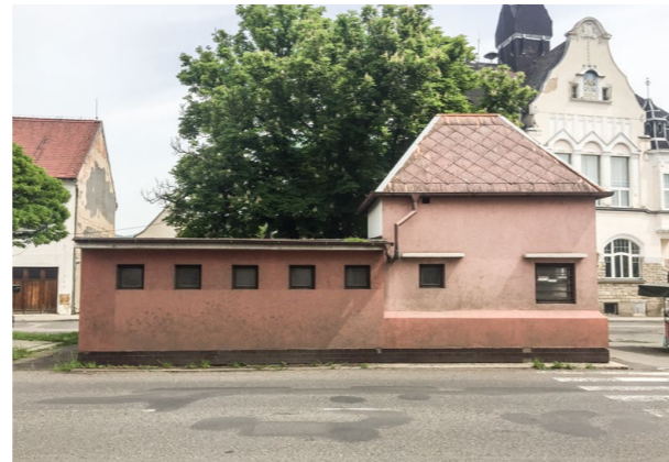
11 BUDOVA TOALET Nevyužívaný objekt ucpává předprostor školy, radnice a blokuje otevření stromořadí do náměstí.
