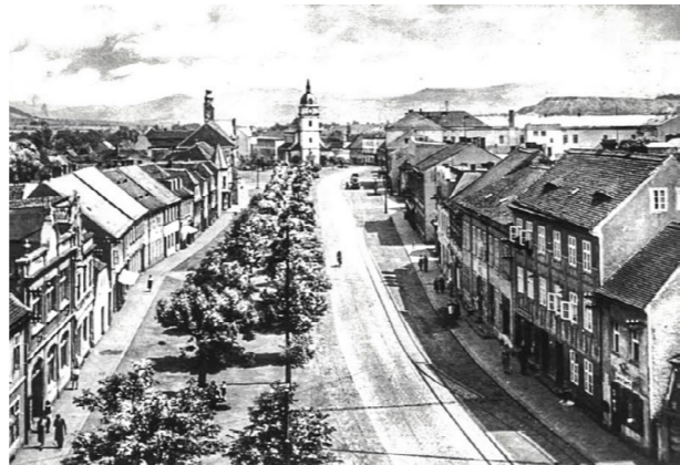
PRŮHLED NA KATOLICKÝ KOSTEL Pohled na opačný konec náměstí.
