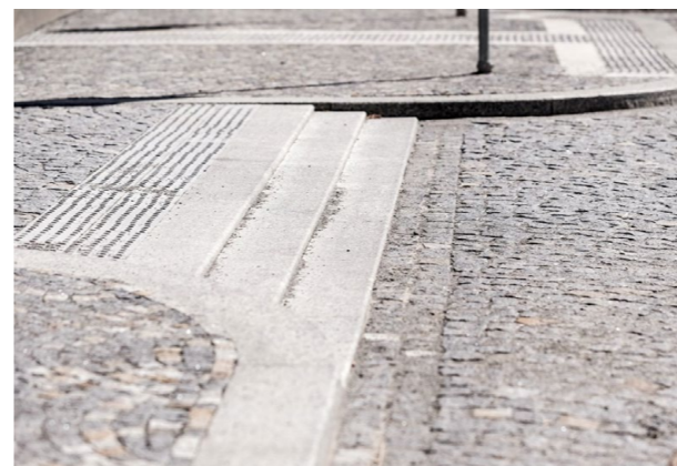
ZPOMALOVACÍ NÁJEZDY U PŘECHODŮ A ZÓN Žulové obrubníky zasezené do betonu zpomalí auta a zvýší bezpečnost chodců.
