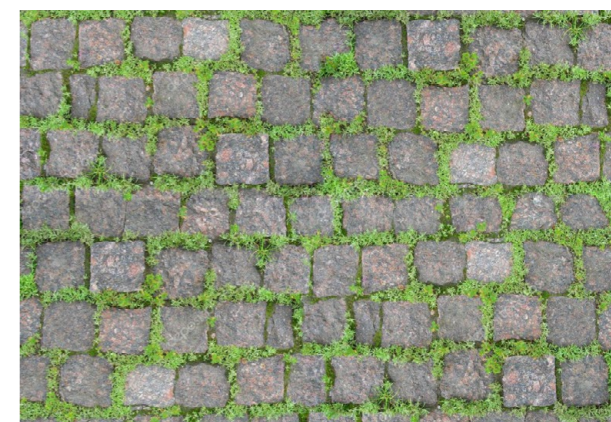
VSAKOVACÍ DLAŽBA SE ZELENOU SPÁROU Používáme ji pro parkovací místa, nebo v okolí kostela, kde chceme dosáhnout zelenějšího efektu.
