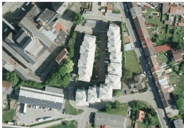
Intenzivnější forma nové výstavby bytových domů pod pivovarem. Nepomáhá tvořit nijak uliční čáru.
