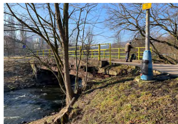
DOŽILÁ LÁVKA PŘES BÍLINU
