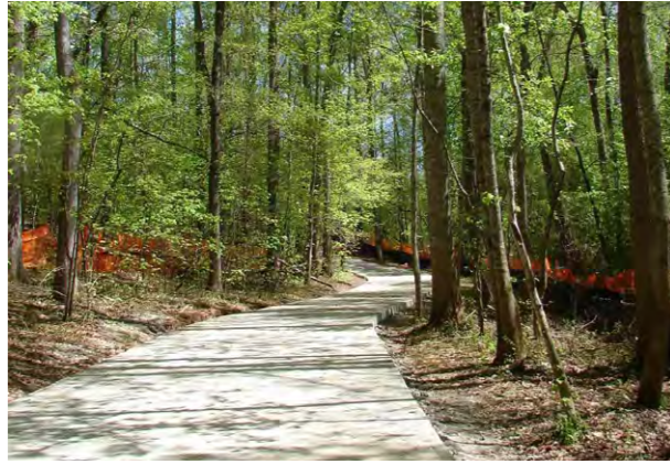
KARTÁČOVANÝ BETON NA CHODNÍKU
