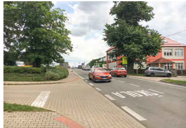
05 ZATEPLENÁ BUDOVA ŠKOLY Původně důležitý dům se starou lípou je dnes zničen zateplením a nemá již velkou hodnotu.
