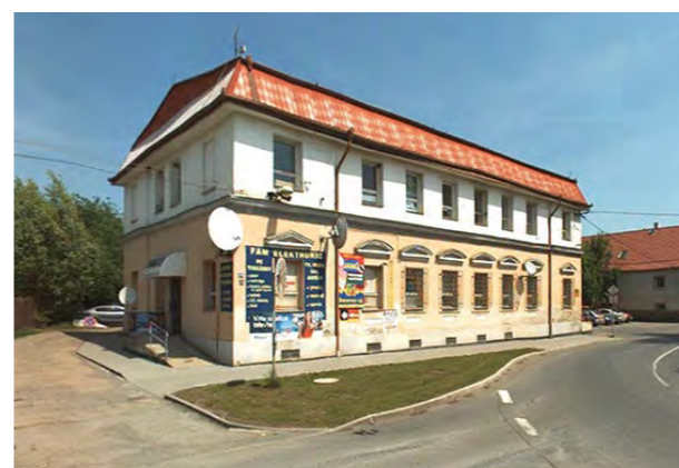
PŘED M1 architekti – Radnice a dům služeb, Libeznice
