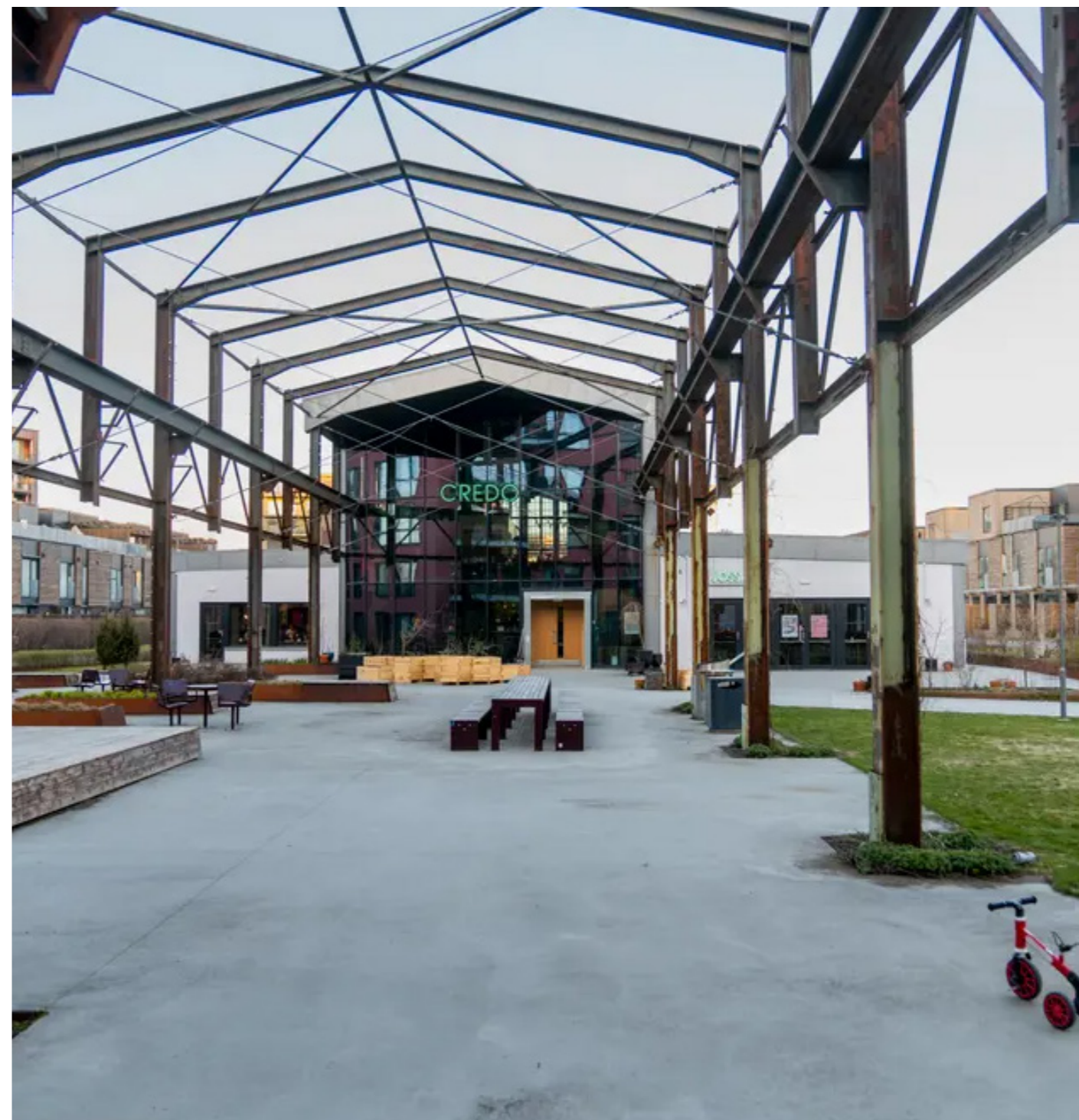
Reference: Příklad bývalé průmyslové stavby, která byla začleněna do smíšené čtvrti, rámuje veřejné prostory a propůjčuje jim identitu.
