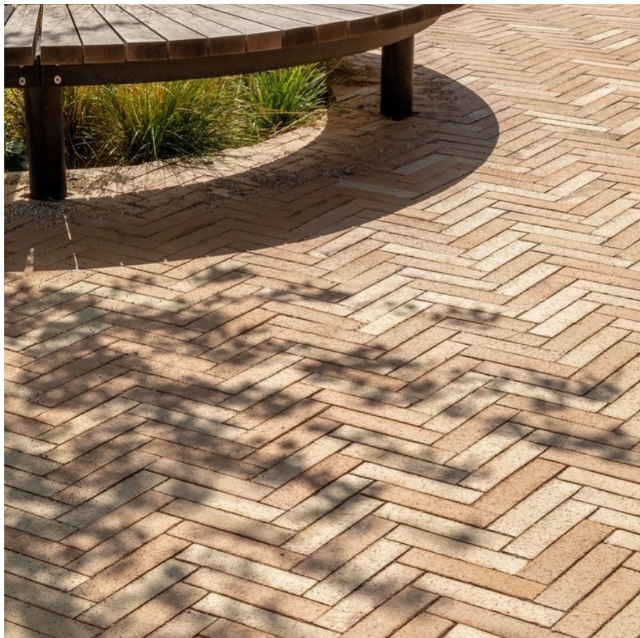
Reference: Nažloutlá cihlová dlažba
