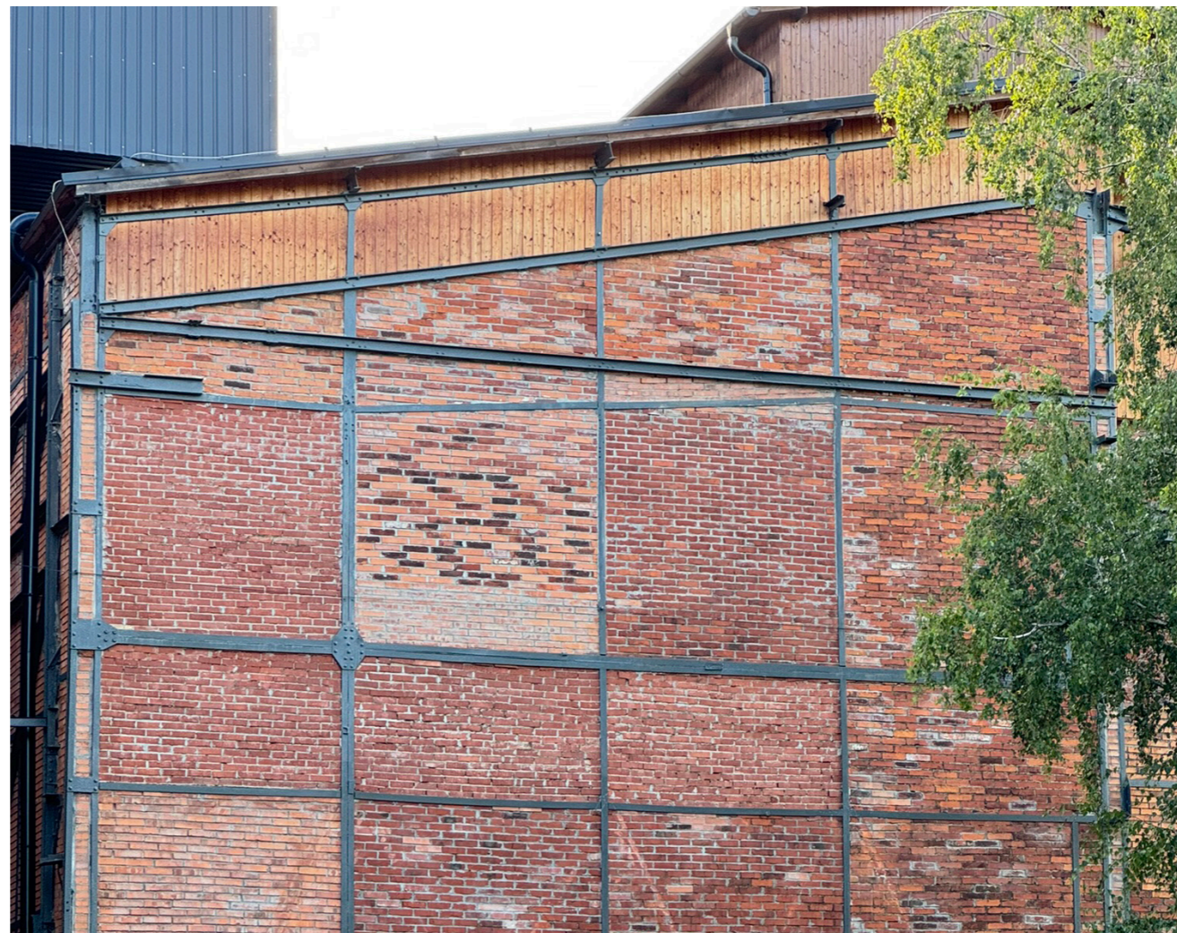
Reference: Rozmanitost odstínů cihel a tmavě zelené ocelové konstrukce v Dolní oblasti Vítkovice, která je příkladem rozmanitosti barev v rámci jednotné materiálové identity.
